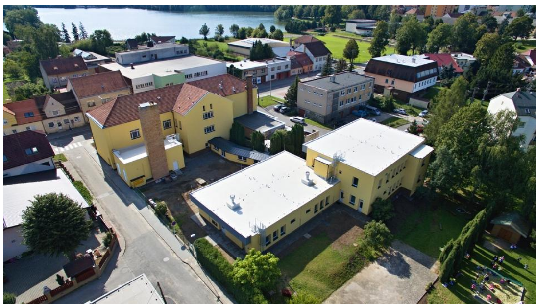
AREÁL BUDOV MATEŘSKÉ ŠKOLY, II. BUDOBA, VCHOD Z ULICE ZAHRADNÍ
